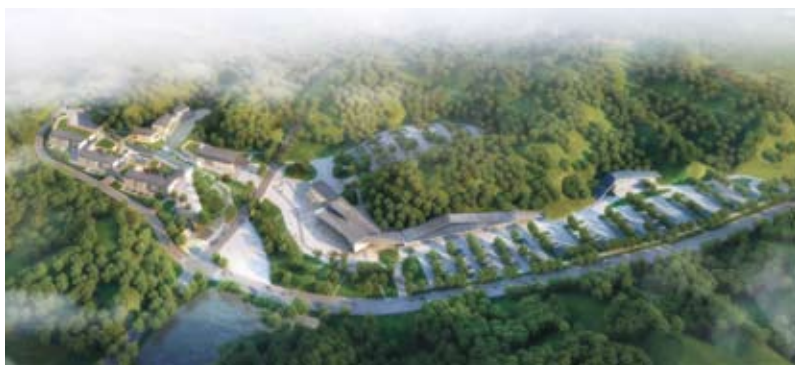
武当山游客集散中心（建设中）
