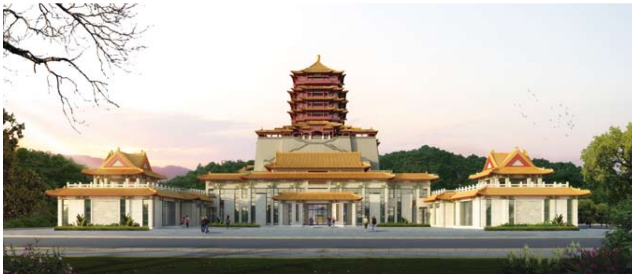
太和楼（建设中）
