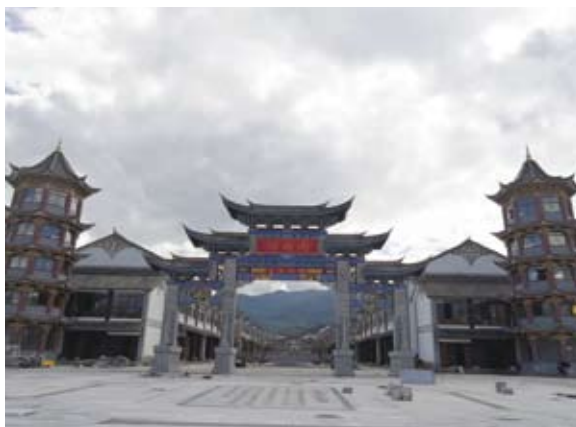
① 正在建设中的步行街
