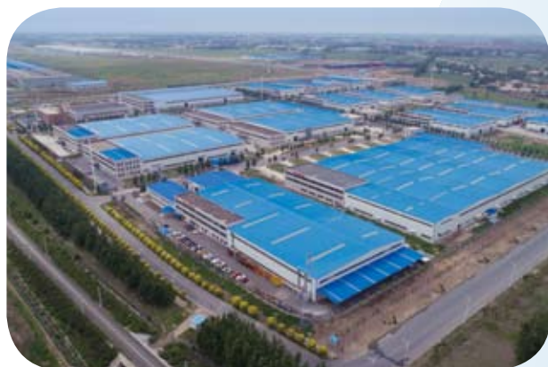
② 装备制造产业园区外景
